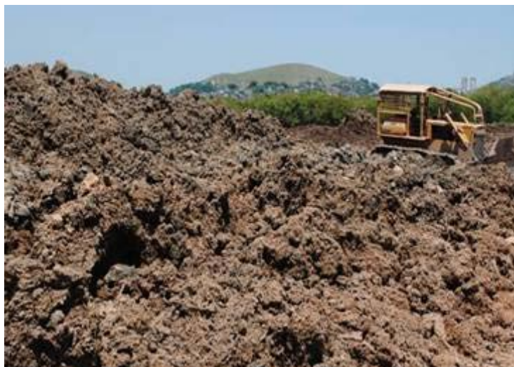
Figura 12 – O material retirado da escavação dos pôlderes é aproveitado para formar os diques sobre os quais será construída a estrada.
