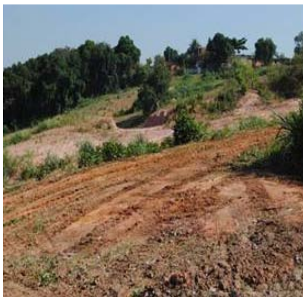
Figuras 10 e 11 – Trabalhos com trator no limite da Área de Influência Direta da rodovia Transbaixada. Retirando a vegetação e a camada superficial do solo; sem um plano correto de recuperação, as encostas serão erodidas pela água da chuva que carregará os sedimentos para as partes mais baixas e para os rios e riachos.
