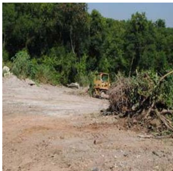
Figuras 10 e 11 – Trabalhos com trator no limite da Área de Influência Direta da rodovia Transbaixada. Retirando a vegetação e a camada superficial do solo; sem um plano correto de recuperação, as encostas serão erodidas pela água da chuva que carregará os sedimentos para as partes mais baixas e para os rios e riachos.
